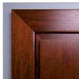
łączenie opasek pod kątem 45°
