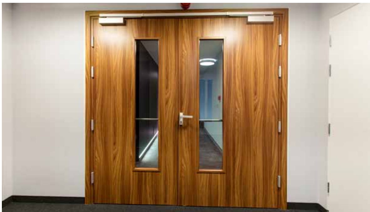
drzwi przeciwpożarowe FR EI30, ościeżnica stała drewniana
