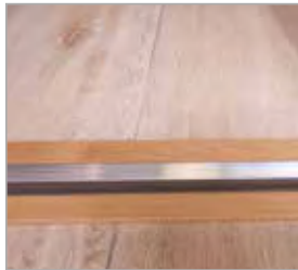
próg dębowy do ościeżnicy drewnianej
