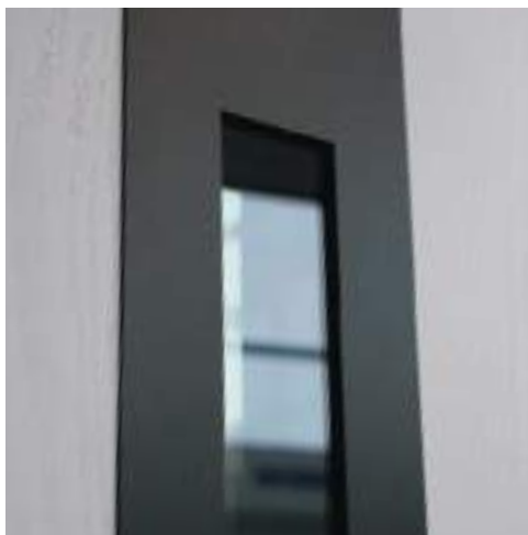
Ramka czarna malowana naklejana na skrzydło
